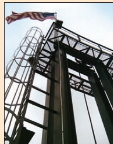
Torre de prueba de malacates en la planta de fabricación de Tulsa Winch ubicada en Tulsa, Oklahoma.
